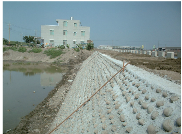
十分塢農地重劃區 - 中排水路格樑框砌石生態設施、擋土牆及農路植栽綠籬
