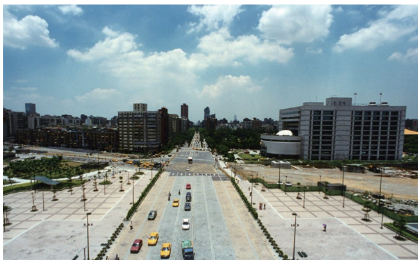
市府前廣場及臺北 101 興建工程施工情形
