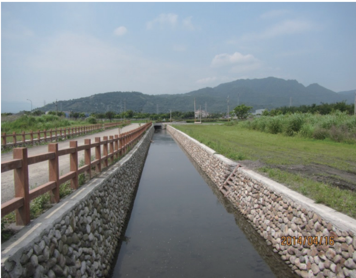
宜蘭縣員山鄉大湖（二）農地重劃區 - 中排水路砌石生態設施
