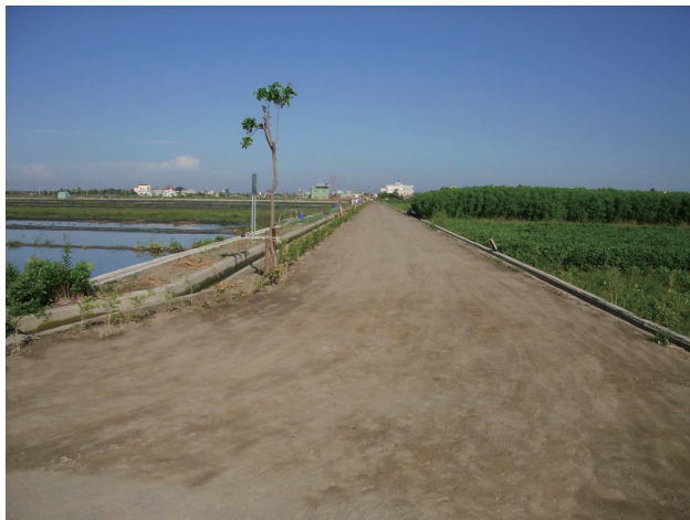
十分塢農地重劃區 - 中排水路格樑框砌石生態設施、擋土牆及農路植栽綠籬
