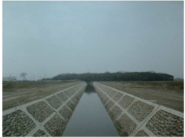
好收南農地重劃區 - 小排水路渠底滲水生態設施及大排水路格樑框砌石生態設施
