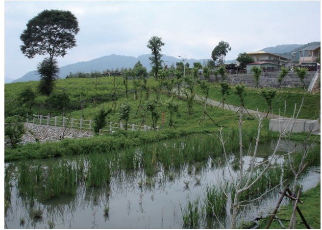
天狗農村社區 - 污水自然淨化池
