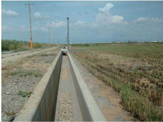
好收南農地重劃區 - 小排水路渠底滲水生態設施及大排水路格樑框砌石生態設施
