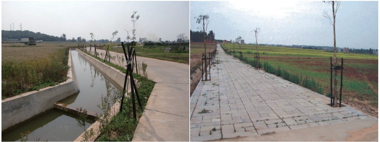
大山頂農地重劃區 - 排水路跌水設施及農路植栽綠籬
